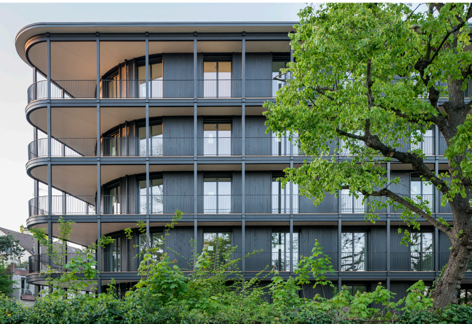
Parc résidentiel de Schaffhauser Rheinweg à Bâle (bardage en sapin suisse abouté, sans nœuds, avec traitement de coloration) © Philip Heckhausen
