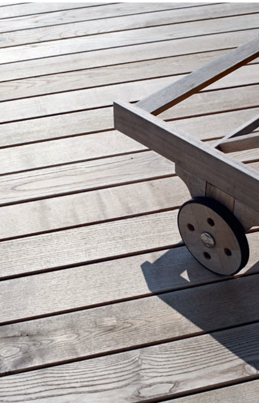
Terrassenboden Schweizer Holz Thermo-Esche, gehobelt, unbehandelt.
