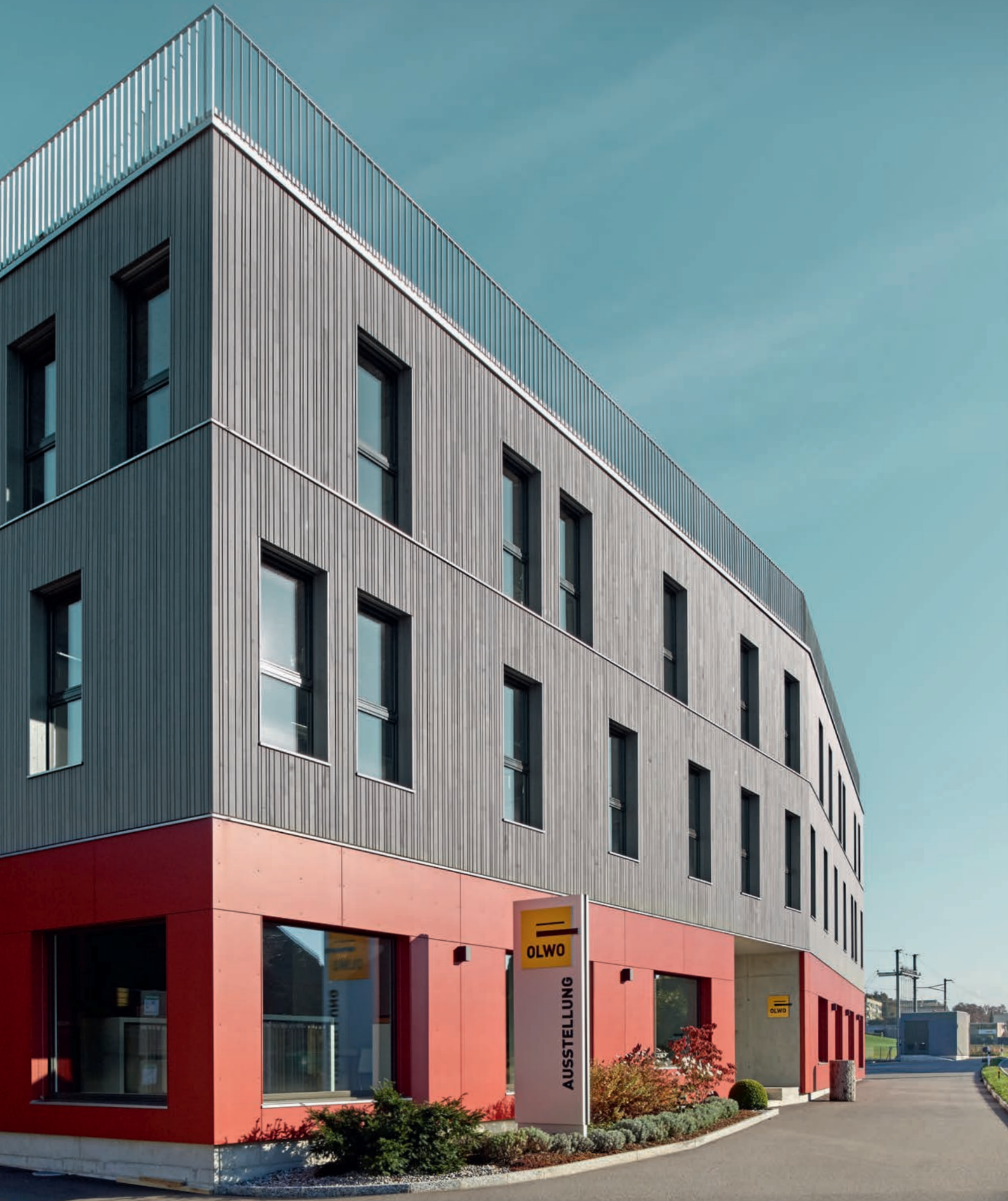
Fassade Schweizer Holz OLWO-Tanne Elegance, sägeroh, Farbbehandlung vorvergraut Impralan Greyback. Fassade MDF Tricoya, Oberflächenbehandlung Perl Color rot.
