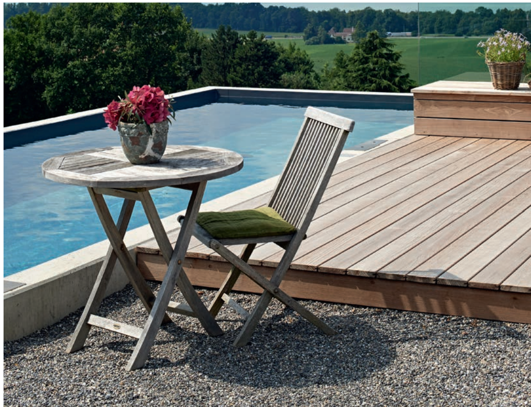
Terrassenboden Schweizer Holz Thermo-Esche, gehobelt, unbehandelt.
