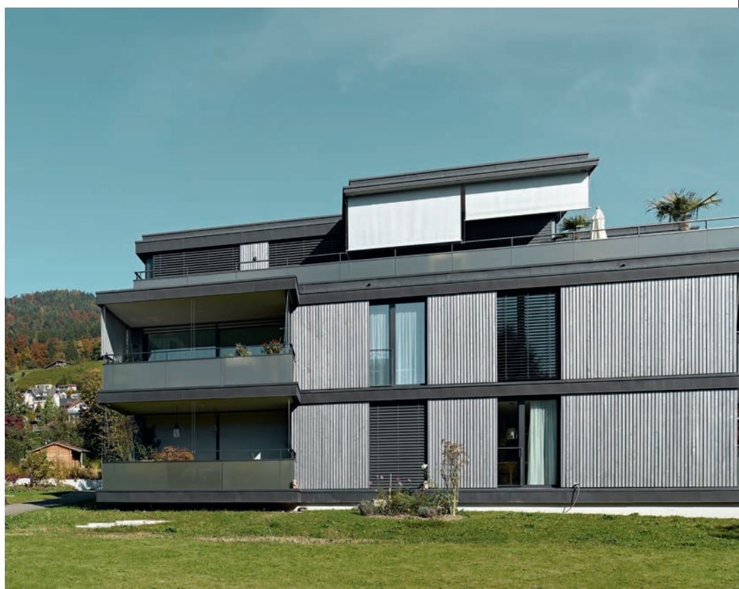
Façade lames épicéa, brut de sciage, imprégnée sous pression, traitement de coloration Impralan Metallic ardoise-anthracite.
