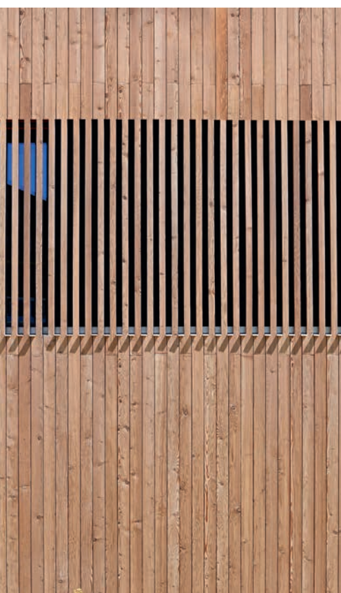
Façade mélèze, rabotée, traitement de surface Wood Care UV incolore.
