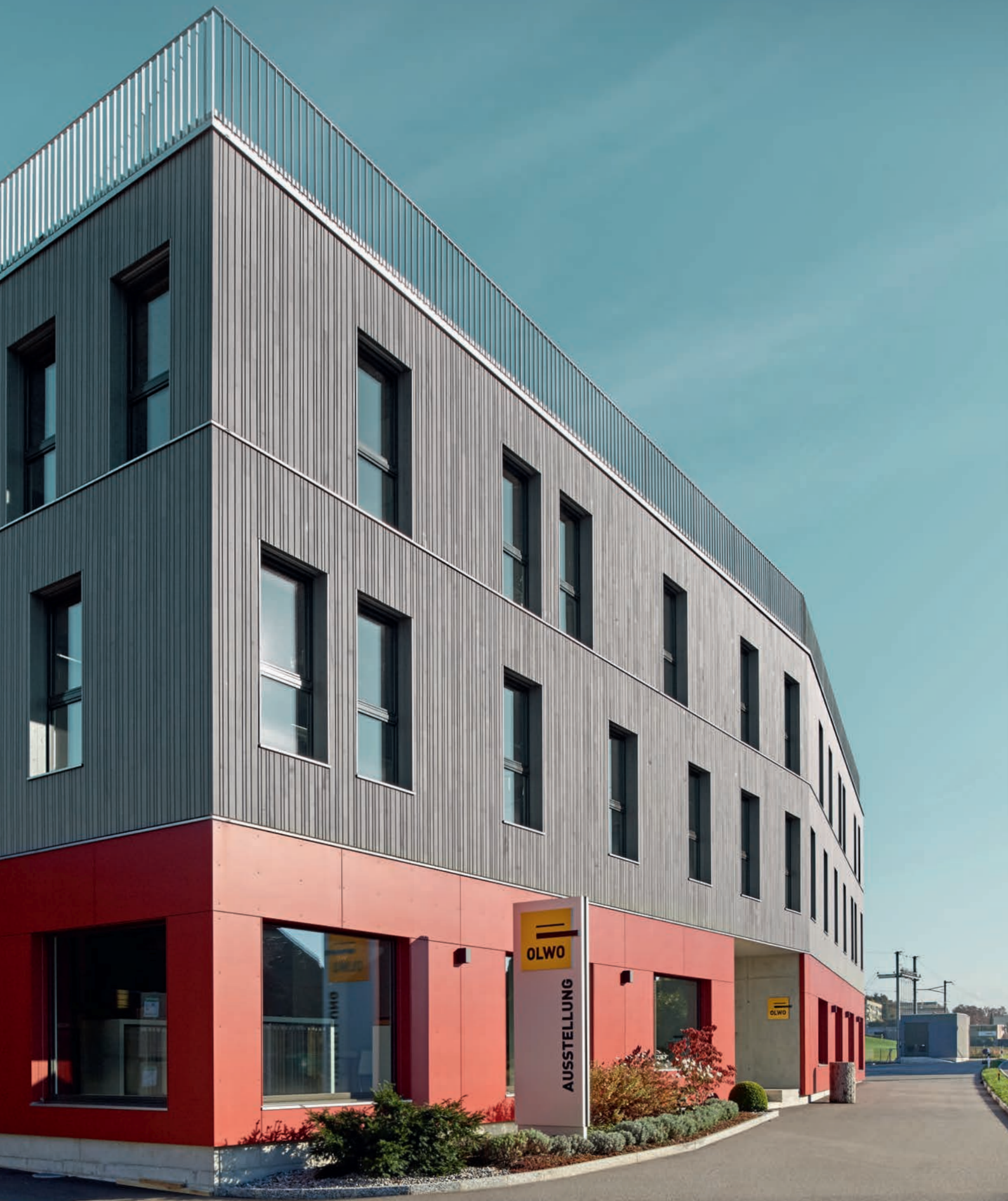
Façade bois suisse OLWO-Sapin Elegance, brut de sciage, prégrisé par traitement de coloration Impralan Greyback. Façade Tricoya MDF, traitement de surface Perl Color rouge.
