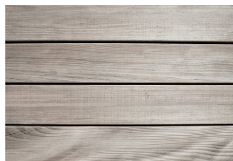
Nach sechs Monaten Bewitterung
